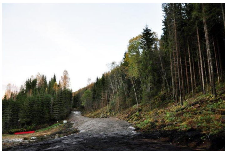
Anleggsarbeider høsten 2015 – ny kunstsno trase
